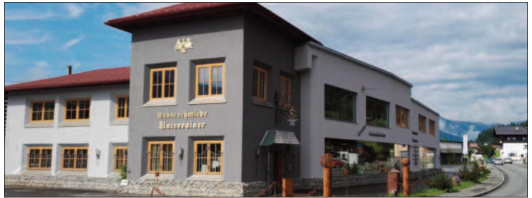
Das neue Betriebsgebäude
