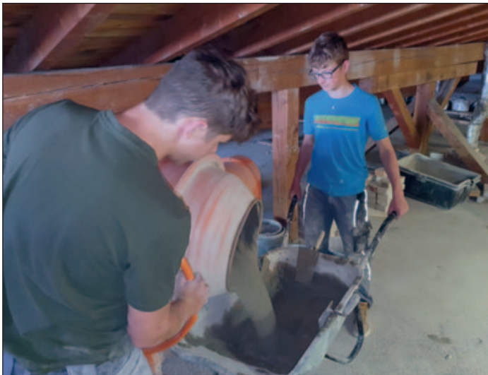
Die richtige Konsistenz des Mörtels ist wichtig!
