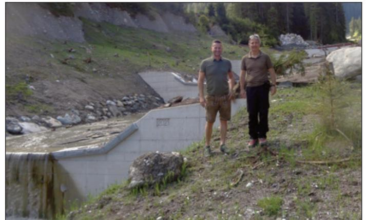
**Die Hinterfüllungen (begrünte Flächen, links) sorgen für Stabilität an den Flanken, die Böschungswinkel sind deutlich abgeflacht.**
