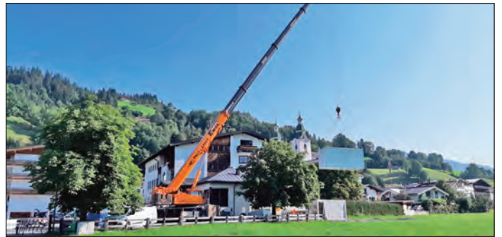
Die neuen Räumlichkeiten für den Kindergarten wurden aufgestellt
