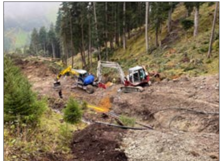
Neue Zuleitung von der Quelle zum Hochbehälter
