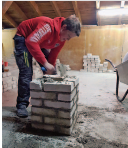
Mauern in der Bauwerkstätte
