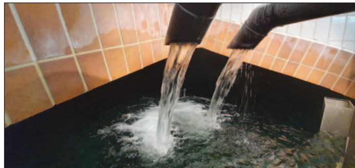
Die Quellzuflüsse speisen den Hochbehälter – die „Herzkammer“ der Brixner Trinkwasserversorgung (Foto: Gemeinde)
