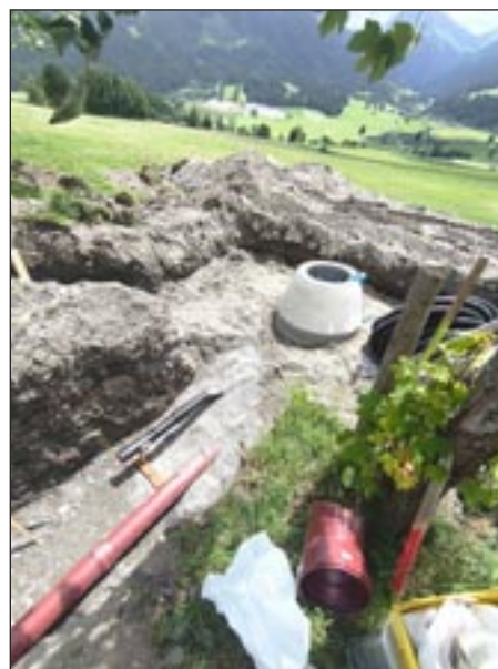
Erschließung der Grabnergründe durch unseren Bauhof
