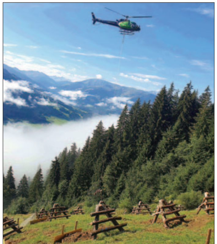
Die Gleitschneeblöcke wurden mittels Hubschrauber eingeflogen.
